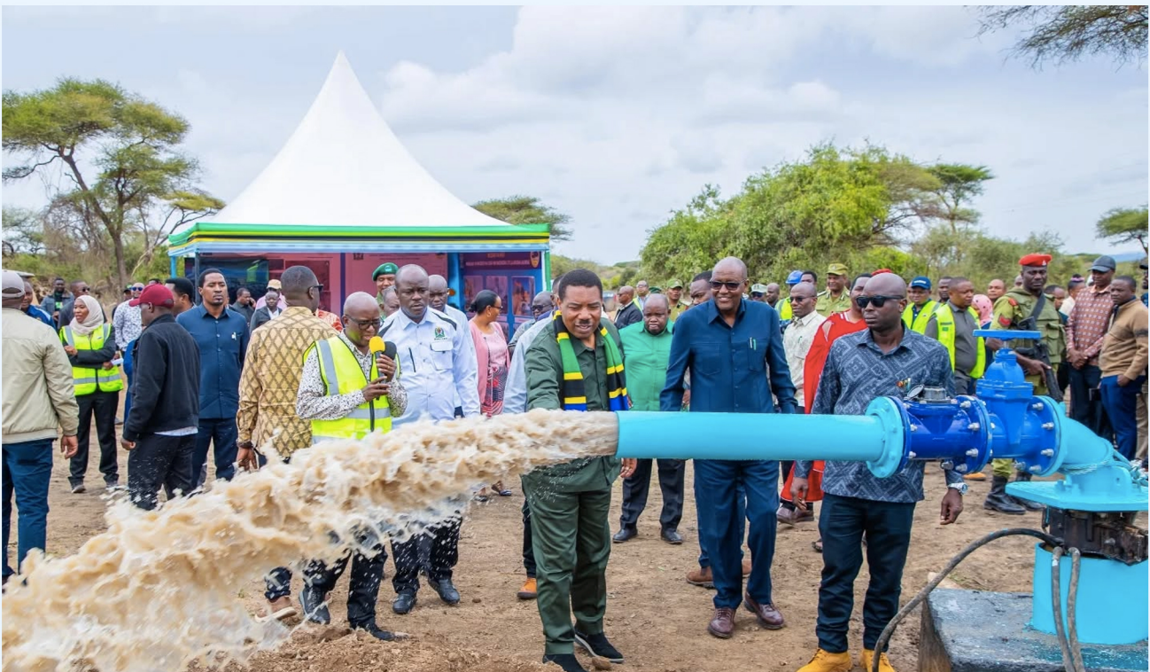
Waziri Mkuu wa Jamhuri ya Muungano wa Tanzania, Mheshimiwa Dkt. Mwigulu Lameck Nchemba (Mb), akikagua Mradi wa Maji Sinya, Wilaya ya Longido na kushuhudia kazi ya kusafisha (flushing) maji kutoka kwenye kisima
